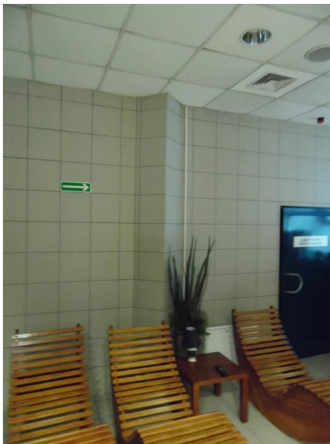
Zdjęcie nr 3.5. Część spa – widoczna konstrukcja słupa.
