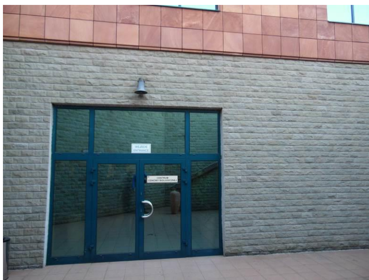
Zdjęcie nr 3.1. Widok budynku ściana wycieczalni zewnętrznej
