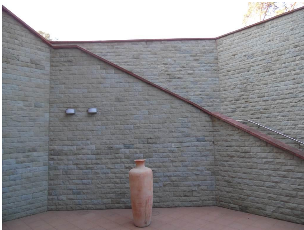
Zdjęcie nr 3.3. Schody zewnętrzne
